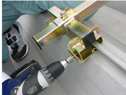
② 上部のM10ボルトを締め込み、支持ステーを固定する。
