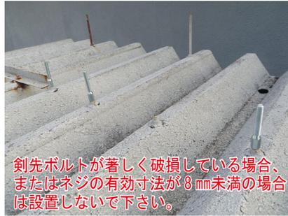
② ボルトスペーサーの上にベース、支持ステーをのせ、座金とM10ナットで締め込み固定する。
