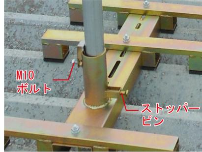
④ ハイテン支柱にロープ保持クランプを取り付ける。
